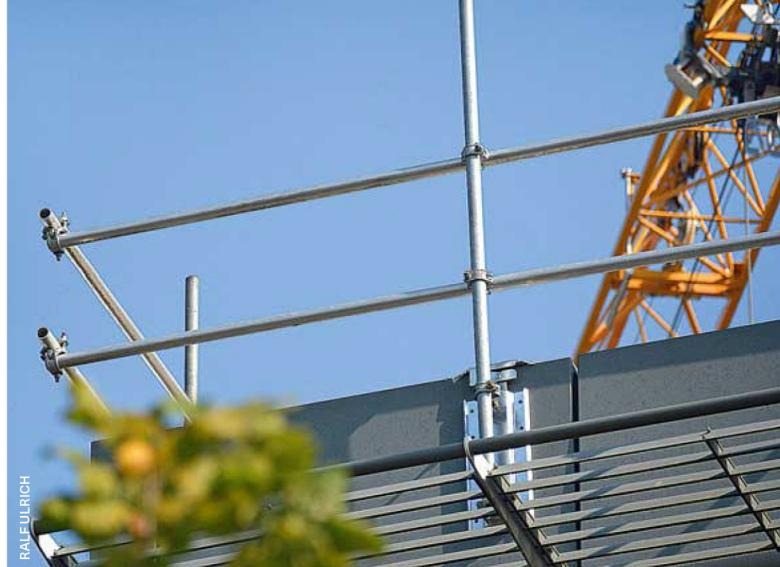
Das Hakos-System zur Flachdach-Sicherung ist DGUV-zertifiziert. Wenn die Ankerplatte montiert ist, lassen sich die Absturzsicherungen mit geringem Aufwand befestigen.
