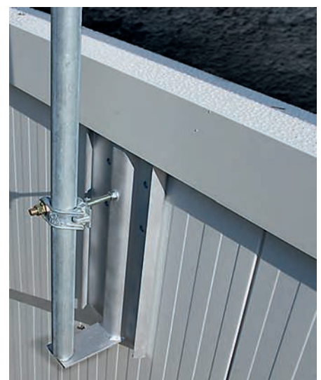
Abb. 10: Komplett montierter Seiten- unfallschutz bei fertig montierter Attika
