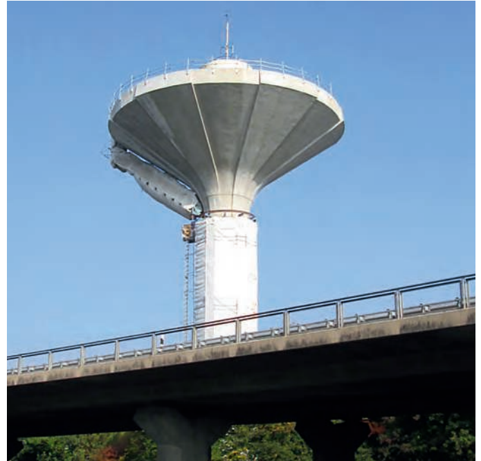
Abb. 1: Bedarfsorientierter Schutz an hohen Gebäuden mit außergewöhnlicher Gebäudearchitektur (System HAKOS, Sanierung Wasserturm Wuppertal)
