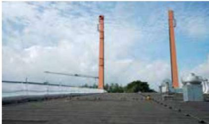
Eine umlaufende Absturzsicherung auf dem Dach sollte Handwerker und Gegenstände während der Sanierung vor dem Herabfallen schützen
