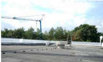
Zwischen die Holme des Seitenschutzes wurde umlaufend ein Schutznetz eingefädelt, um für zusätzliche Absturzsicherheit zu sorgen
